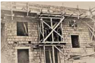
Wohnhaus im Rohbau
