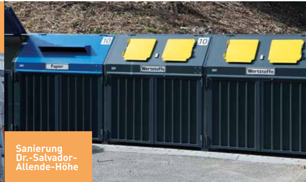
Sanierung Dr.-Salvador- Allende-Höhe
